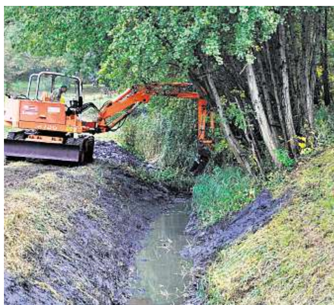
Letzte Vorbereitungen fürs Fischerfest am heutigen Samstag (ab 9,30 Uhr): Der Ablaufkanal des Großen Teiches wurde mit einem Bagger entschlammt.
