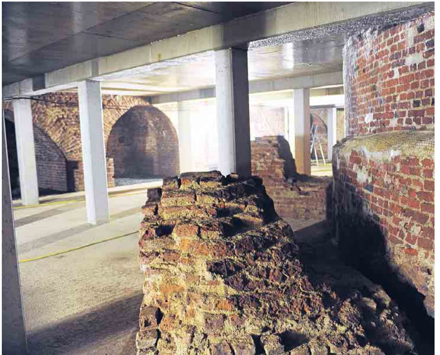
Die modernen Betonträger stehen im direkten Kontrast mit den historischen Fundamenten.
