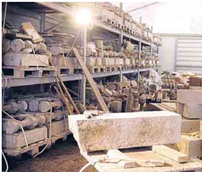
Unzählige kleine Einzelsäulen der Balustrade werden in einem Zelt an der Dachterrasse saniert.
